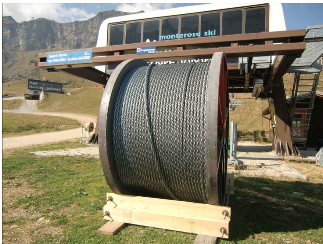
Figura 7.4. 1/5 Montaggio della fune
